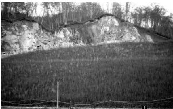
奥入瀬溪流沿いの国道沿線での山崩れ
