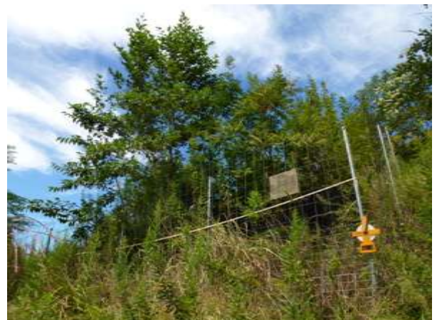
写真3 H19年植栽「盛土法面」
