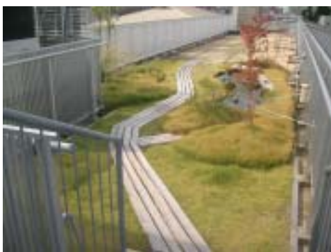
写真5 施行後の屋上の様子
