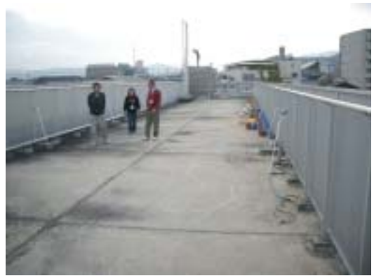
写真3 施行前の屋上の様子
