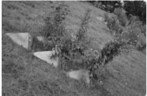
写真5．小型分解性植栽基盤柵を用いた苗木植栽
