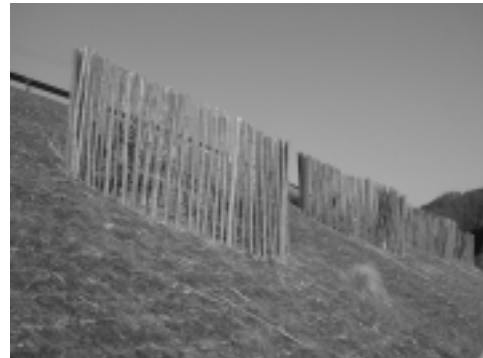
試験区にて竹製防鹿柵を設置 （2003年2月17日）
