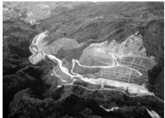
岩井川ダム全景
